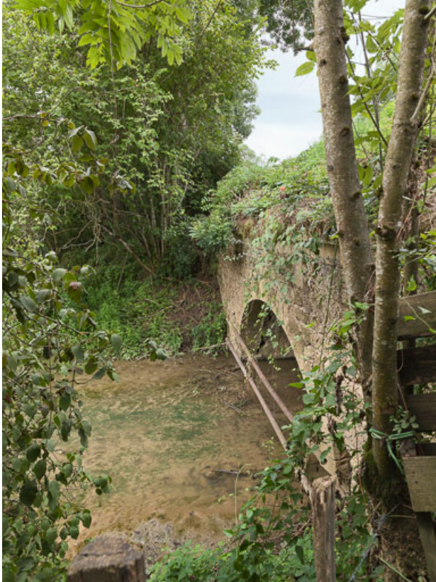
Vue de l'aqueduc.
