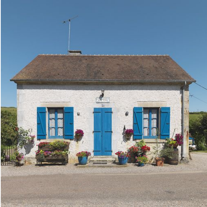
Vue de face de la maison éclusière.
