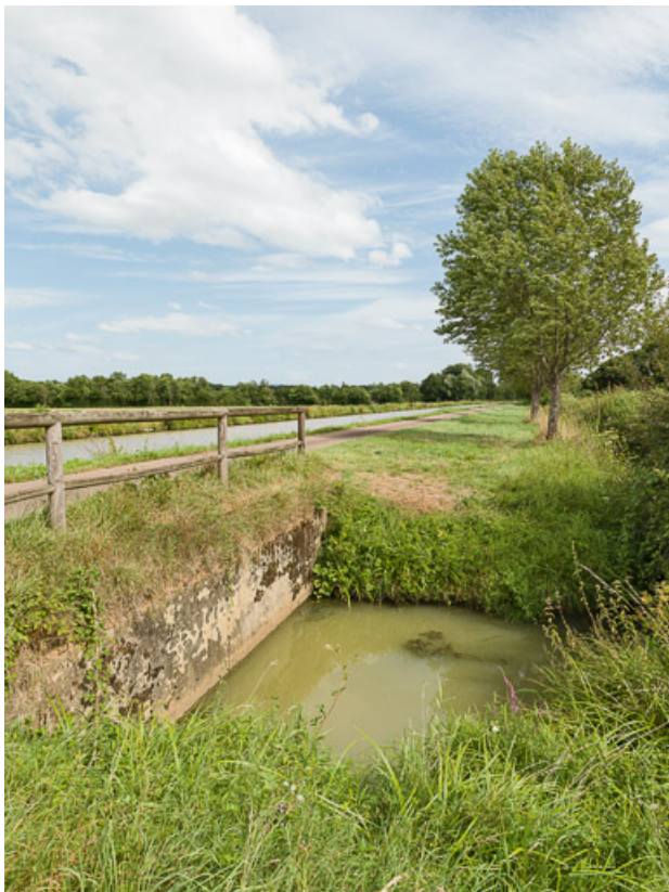
Vue de l'aqueduc.
