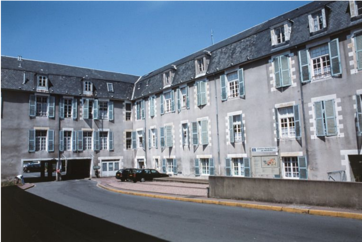
Façade postérieure, partie gauche.
