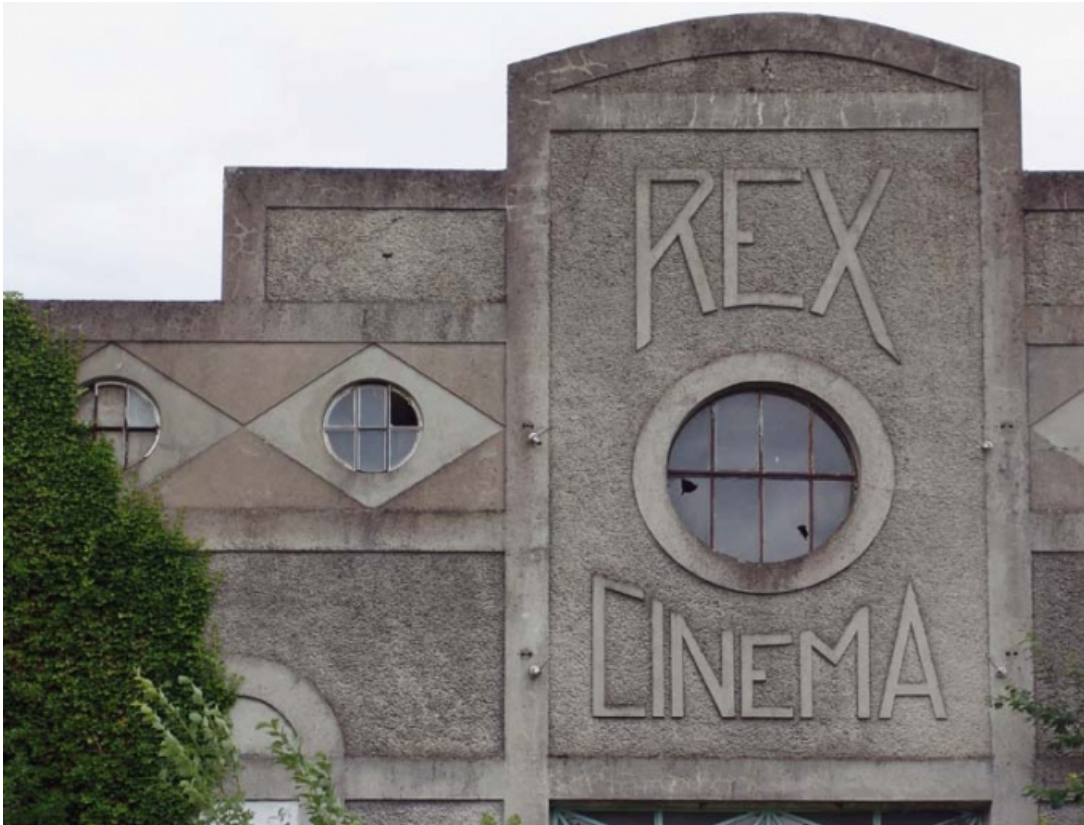
Elévation principale, en 2005 : décor en partie haute.
