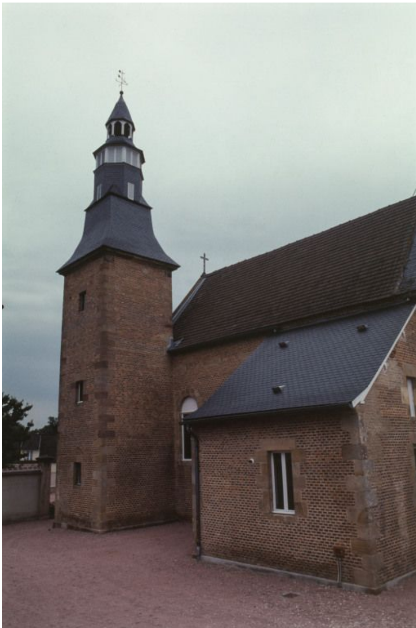
Vue d'ensemble du bâtiment, façade latérale droite.
