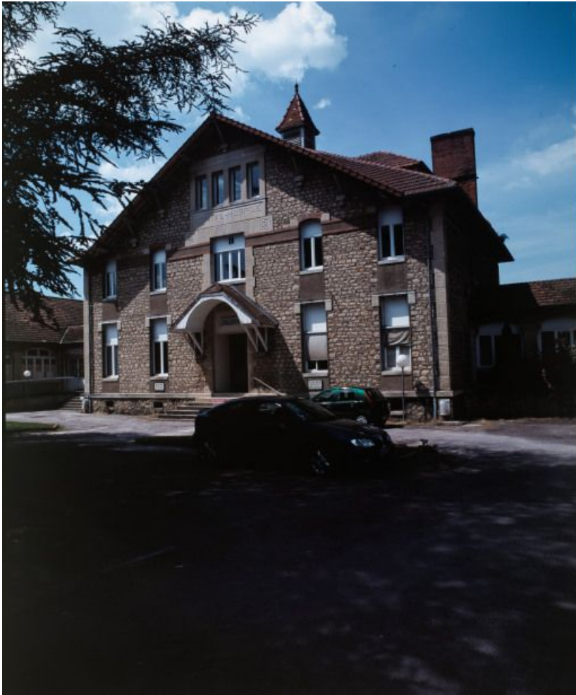
Bâtiment principal, façade antérieure.
