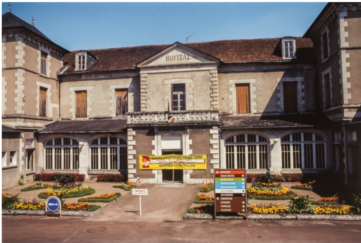
Bâtiment principal, façade antérieure.
