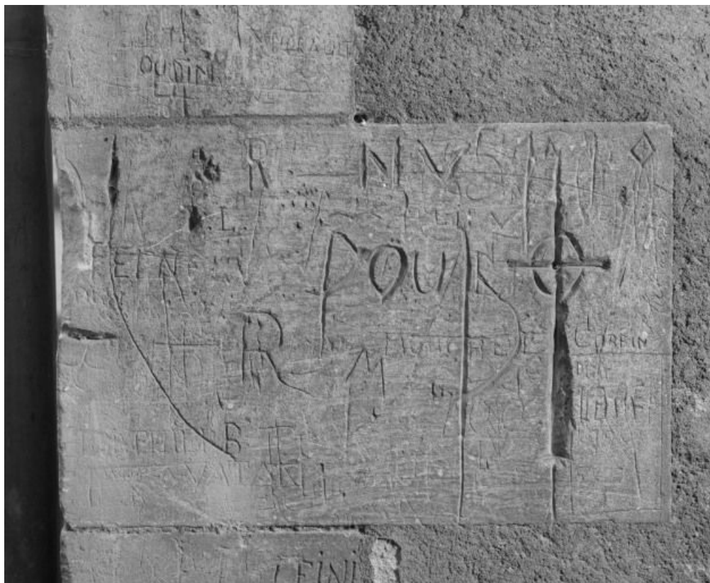
Graffitis sur l'aile militaire du bâtiment principal.
