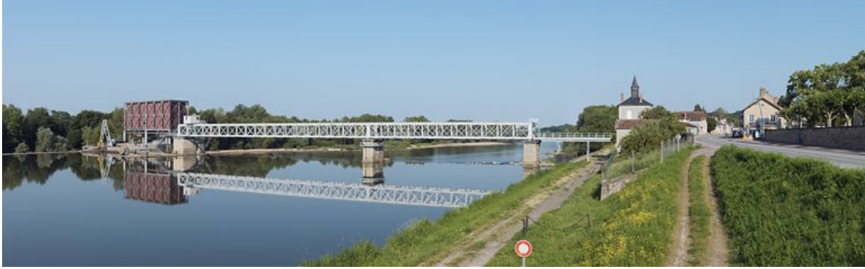
Vue d'ensemble du barrage.
