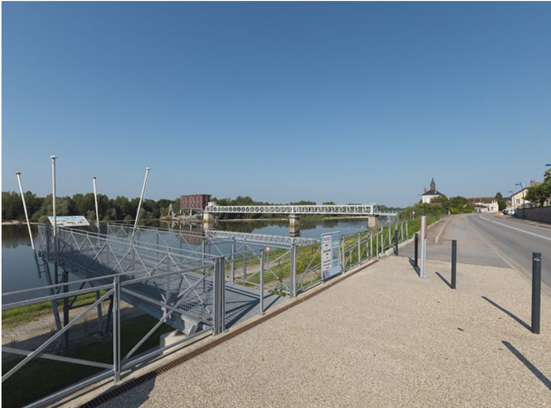
Vue d'ensemble du barrage.
