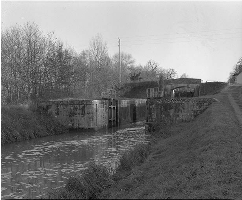
Le pont et l'écluse. Vue d'ensemble.
