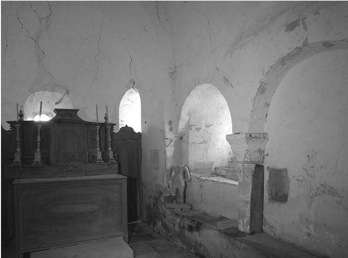
Mur droit du chœur.
