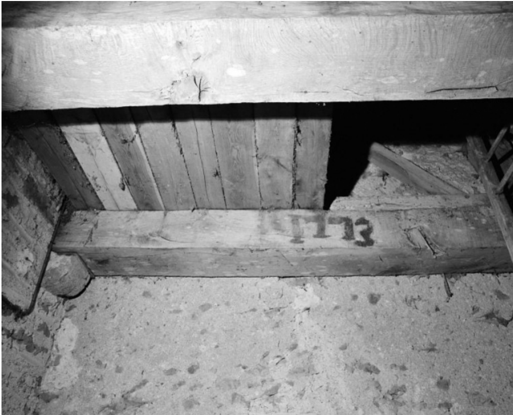
Clocher, poutres supportant le beffroi.
