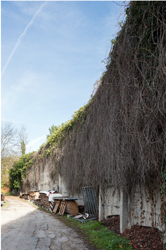
Mur de soutènement, depuis le sud.
