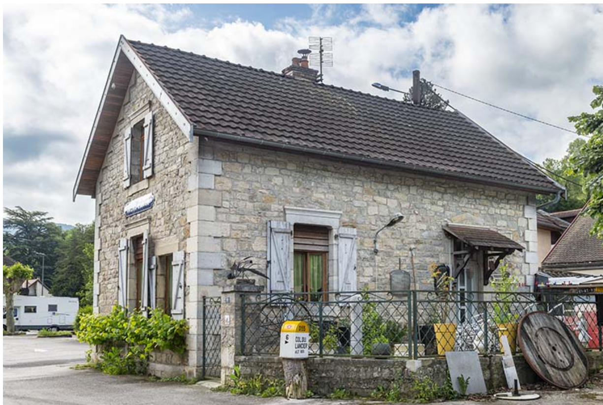
Vue depuis le nord-est.
