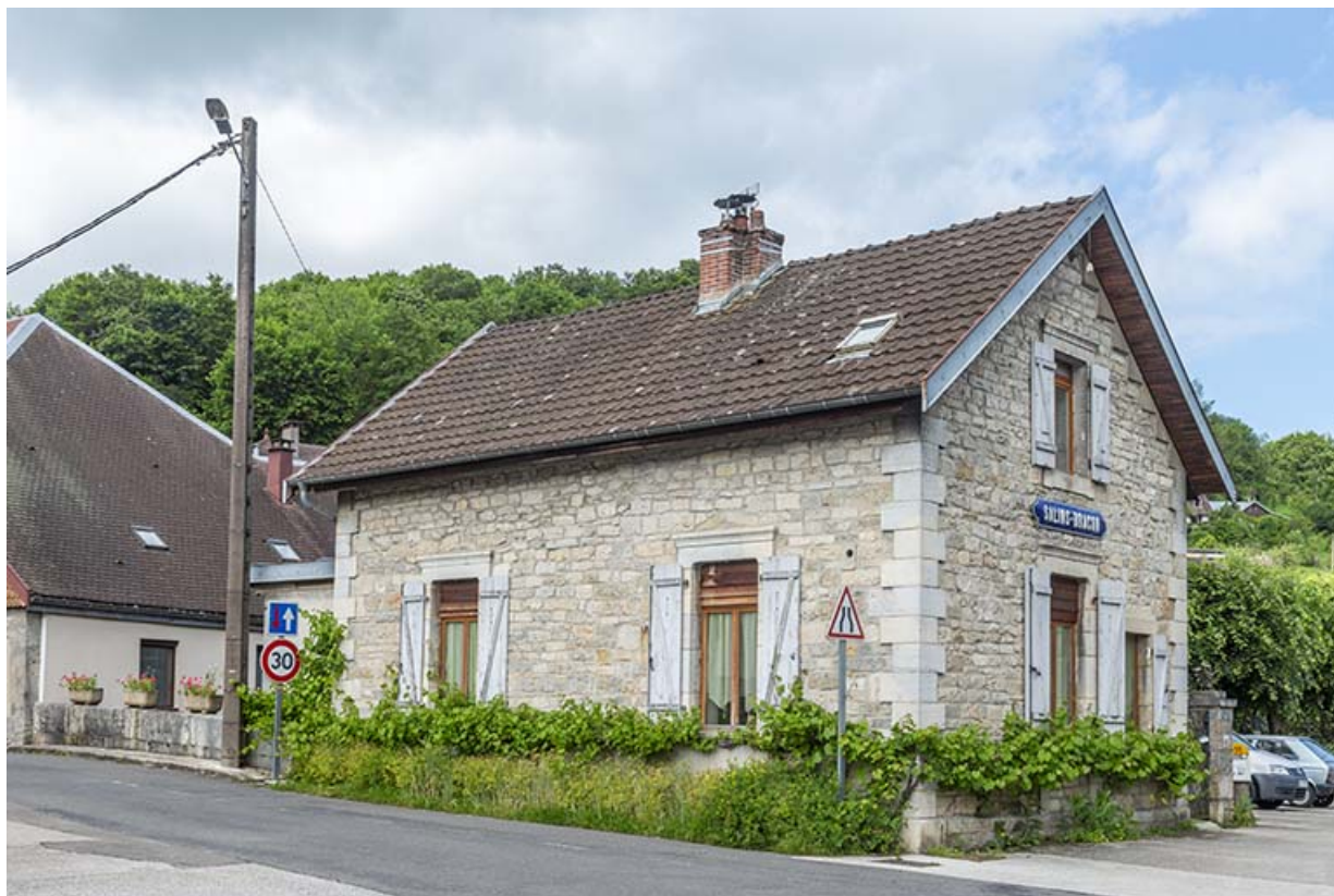
Vue depuis le sud-est.
