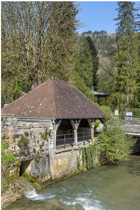
Vue depuis le sud-est.
