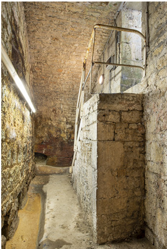
Pièce de captage des sources.
