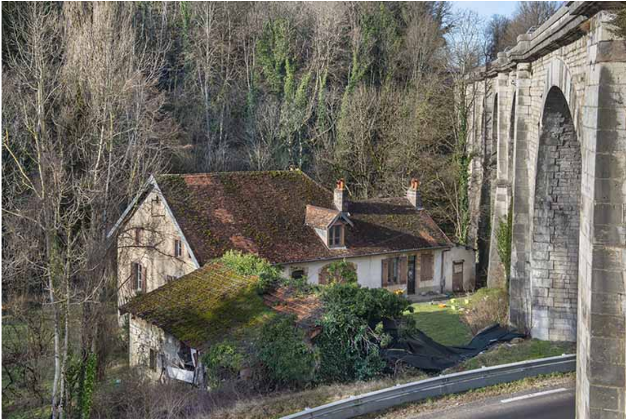
Virage et viaduc, vus de trois quarts.
