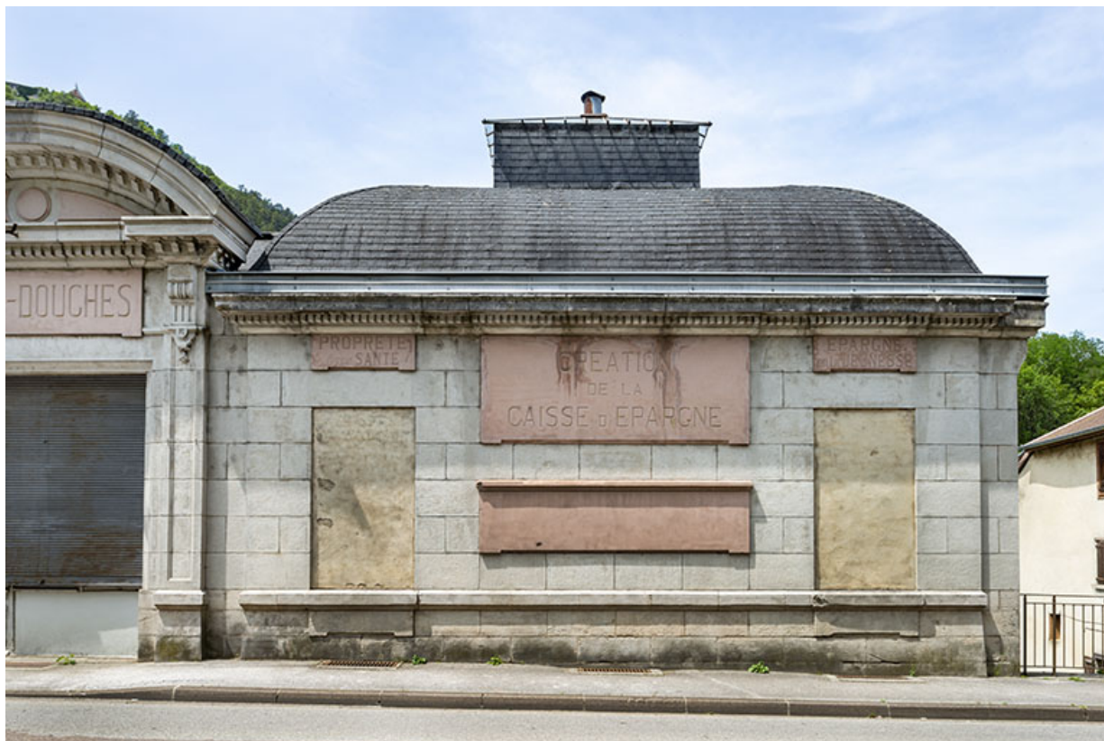
Elévation sur rue du pavillon nord.
