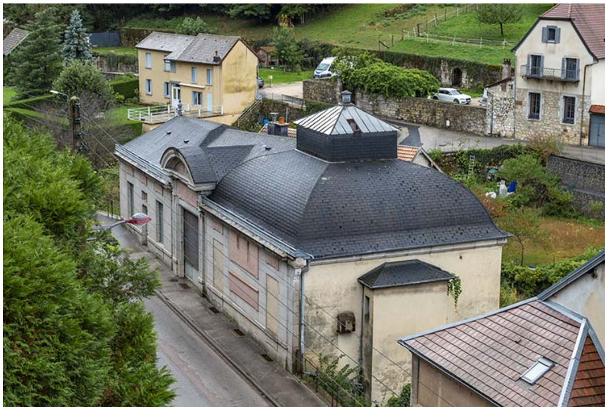
Vue plongeante depuis le nord-est.
