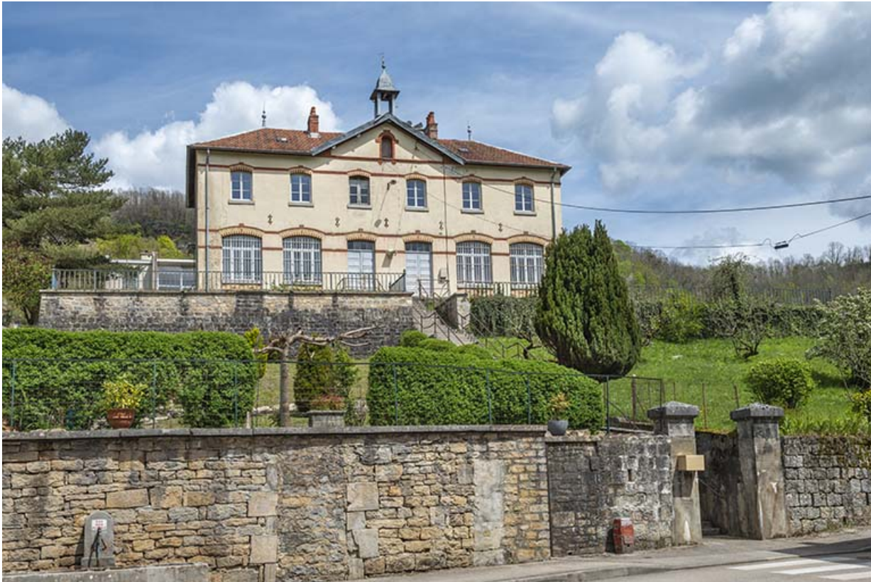
Vue d'ensemble depuis la rue des Prémoureaux.
