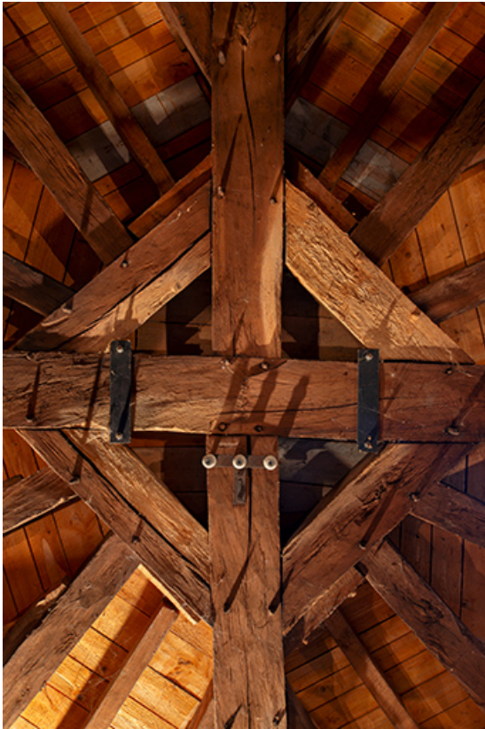
Charpente du dôme. Enrayure centrale.
