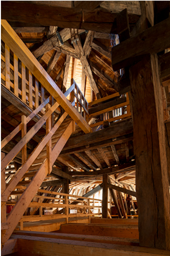
Beffroi du dôme, en contre-plongée, depuis l'est.
