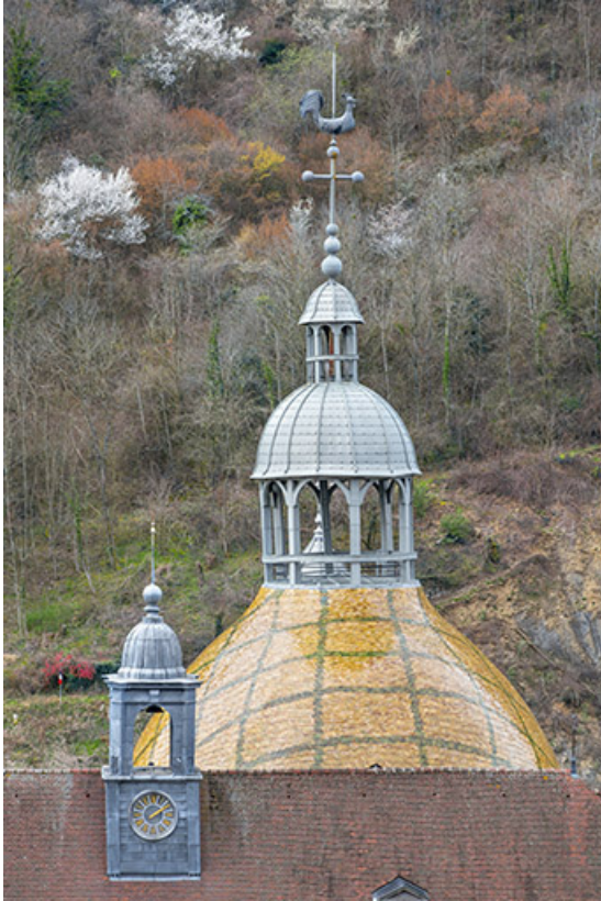
Vue de la coupole depuis l'est.
