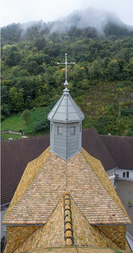
Toiture de la sacristie, depuis le lanterneau.
