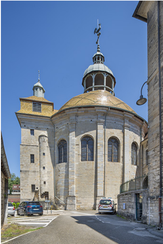
Vue depuis le sud.
