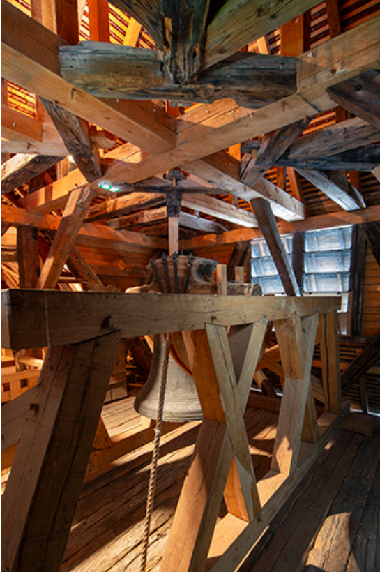
Campanile de la sacristie. Charpente du beffroi.
