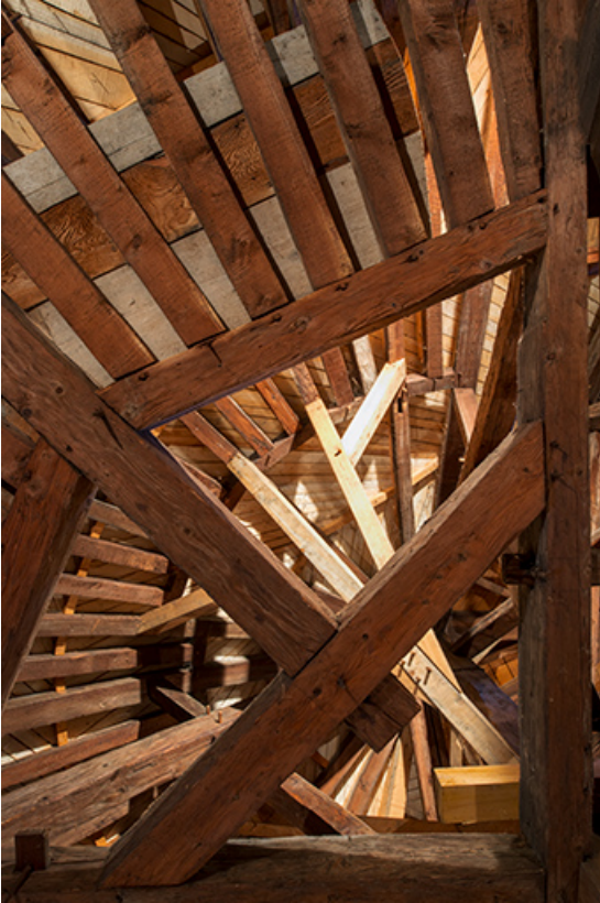
Enrayure nord-est de la charpente du dôme.
