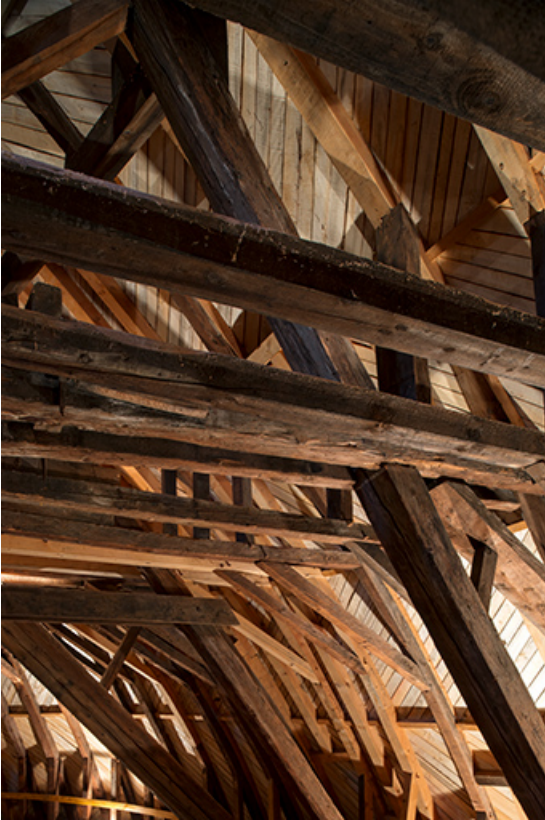
Coté sud, vu depuis l'ouest.
