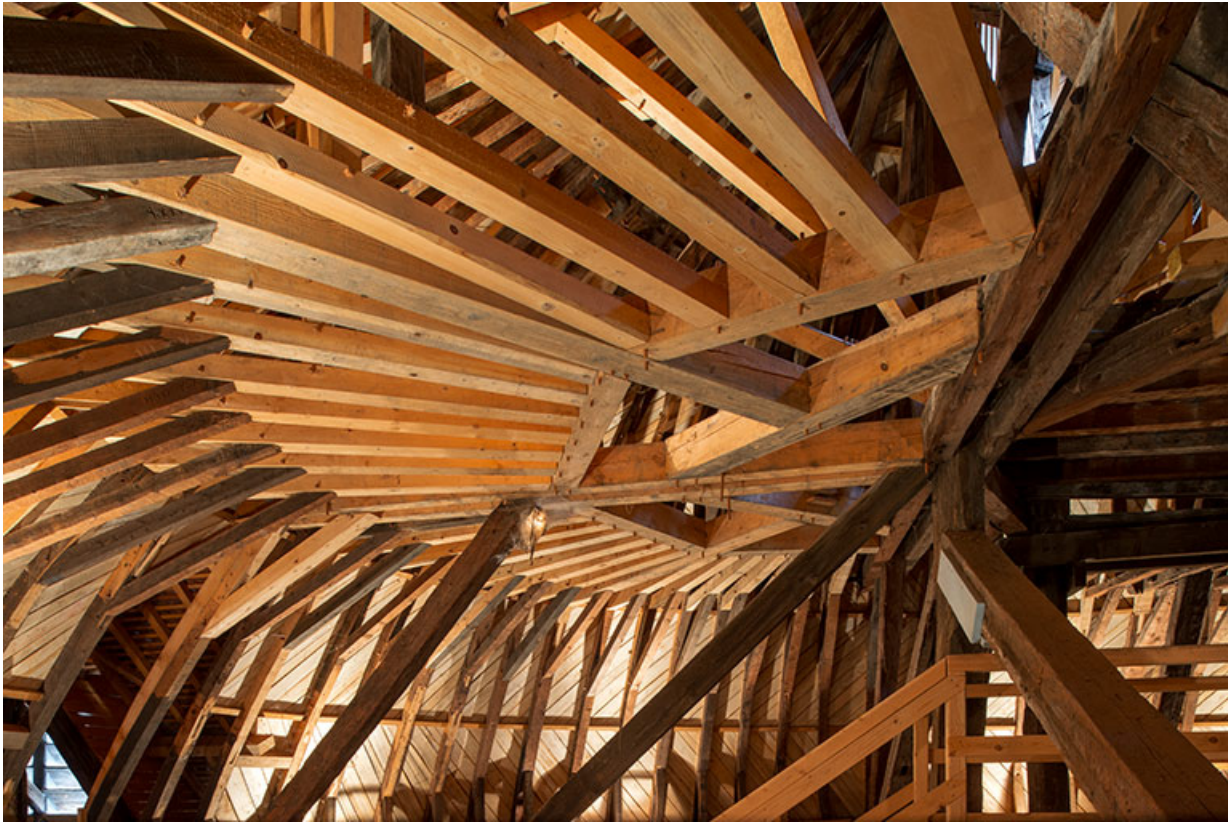
Enrayure du côté occidentale, depuis le sud.
