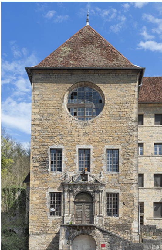
Façade ouest de la chapelle.
