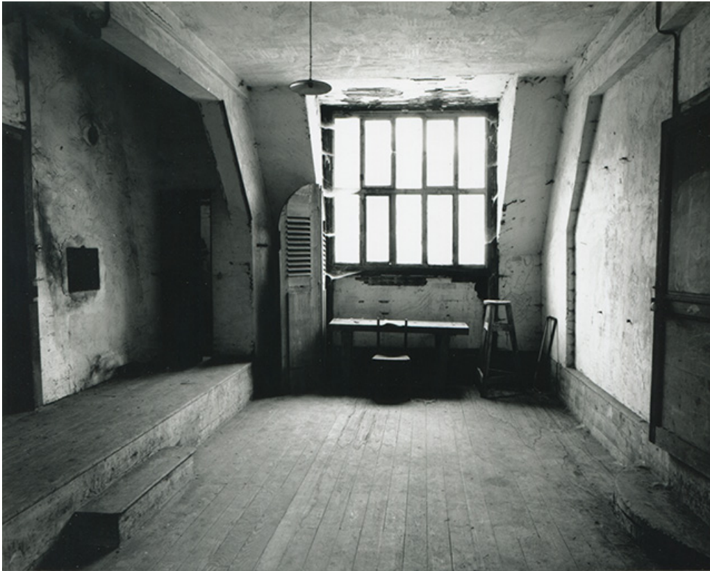
Etage de comble du bâtiment conventuel. Atelier, 1997.
