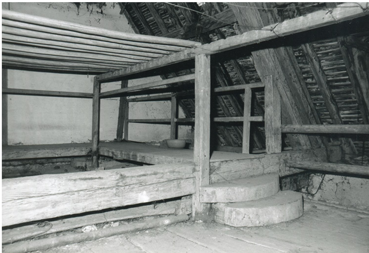
Etage de comble du bâtiment conventuel. Etendoirs (?), 1997.
