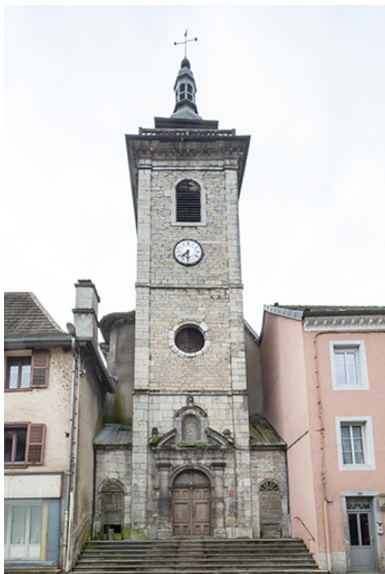
Elévation nord du clocher de l'église.
