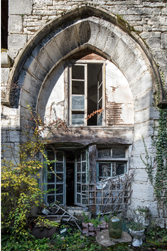
Fenêtre à arc brisé du chevet.
