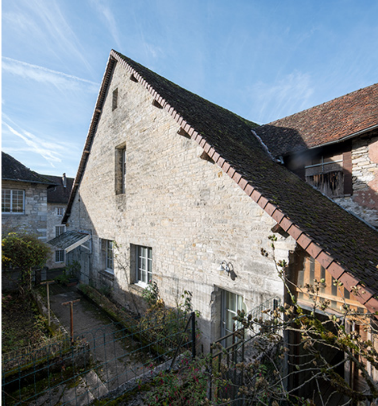
Mur-pignon est de la maison du Temple.
