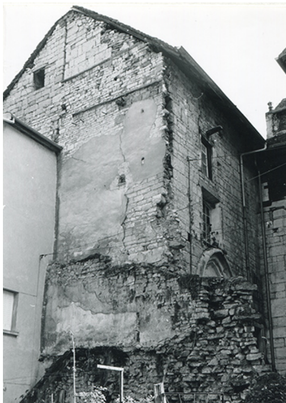
Mur-pignon ouest de la chapelle, 1990.
