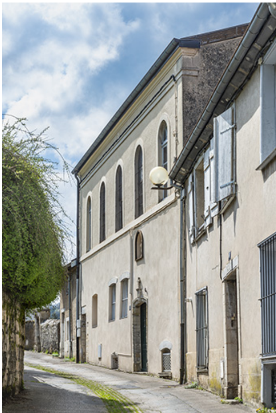
Façade antérieure vue de trois quarts droite.
