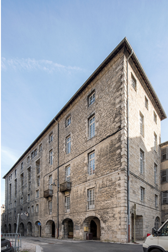
Elévation sur rue depuis le sud-ouest.
