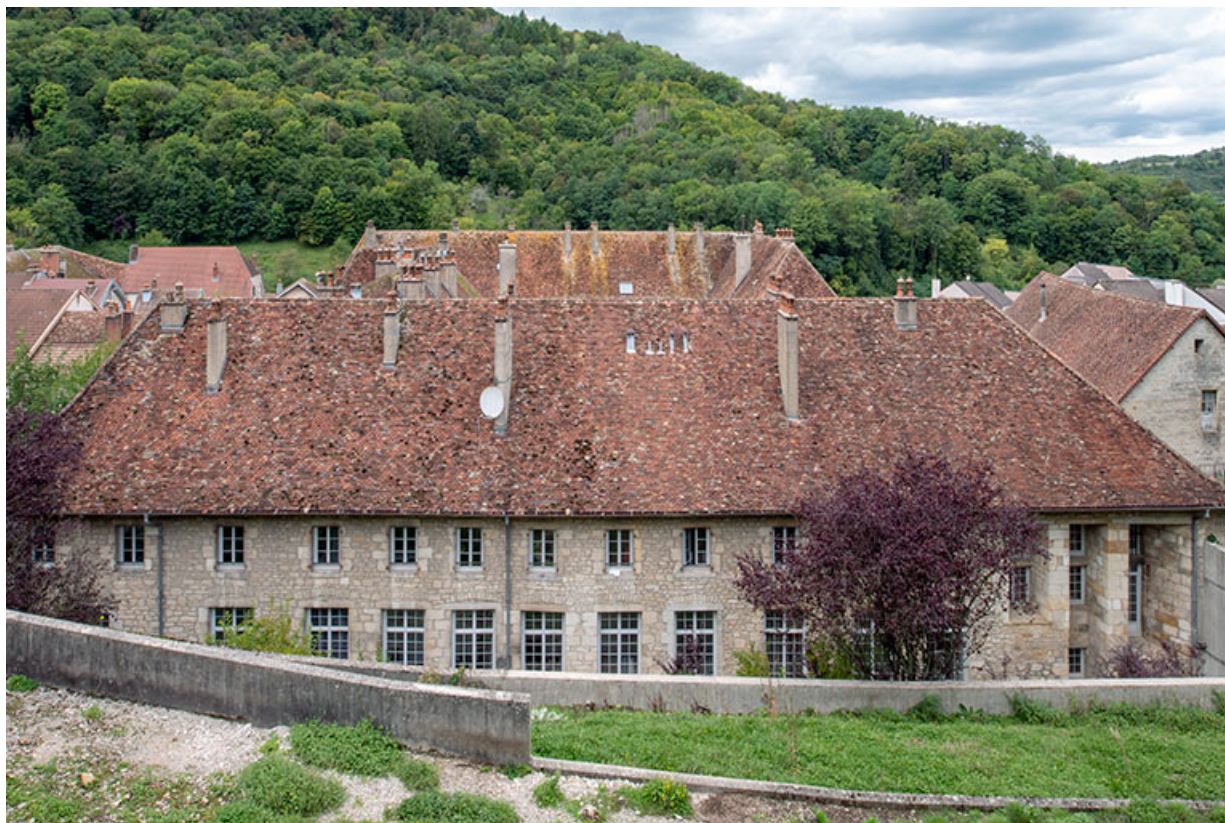
Bâtiment amont. Façade est.
