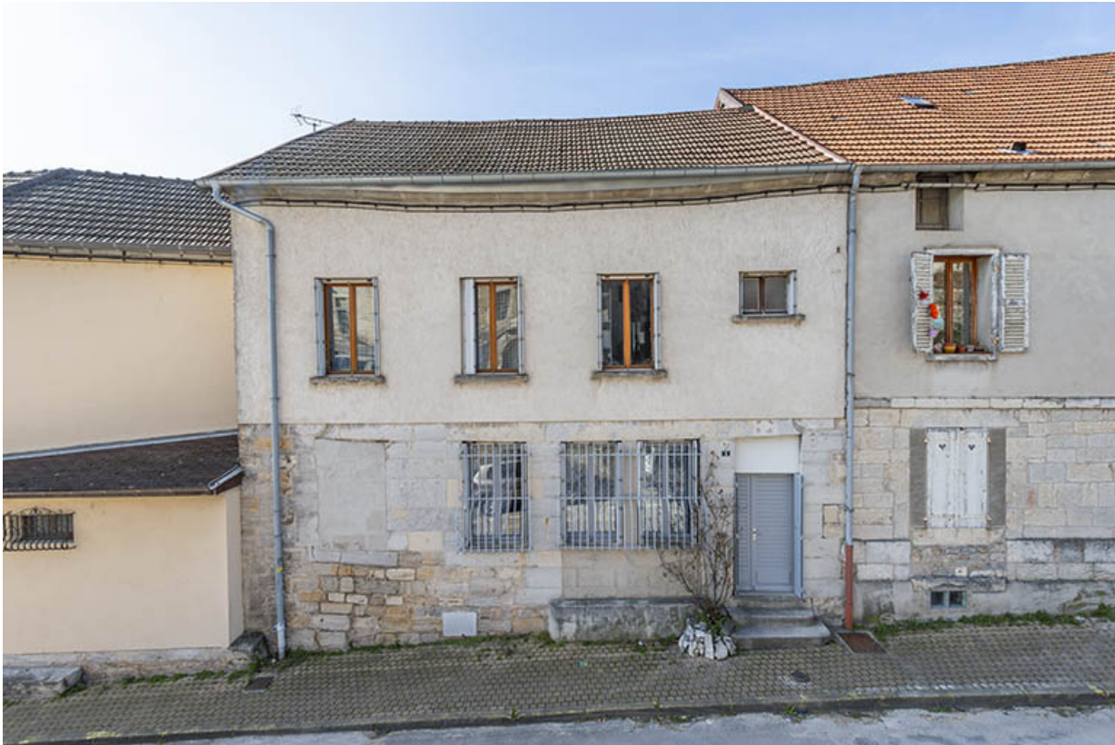
Façade est (rue Charles David).
