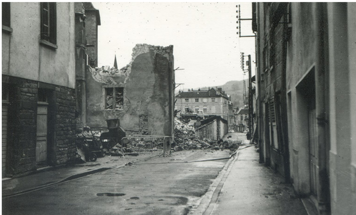
Démolition des bâtiments, vers 1973.
