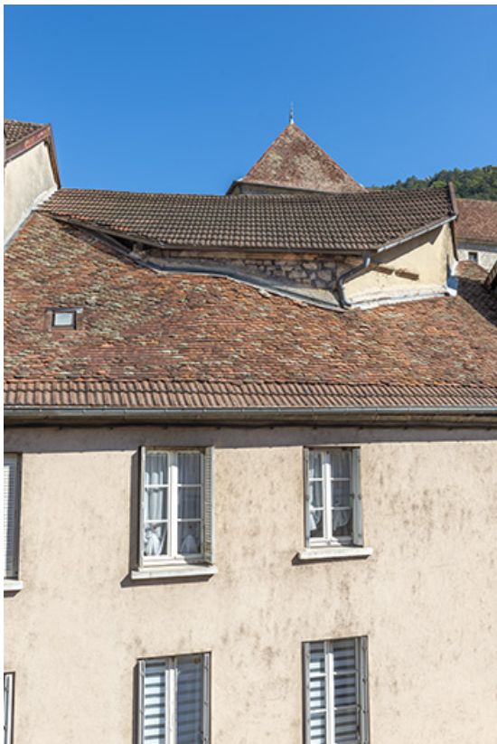
Versant ouest du toit.
