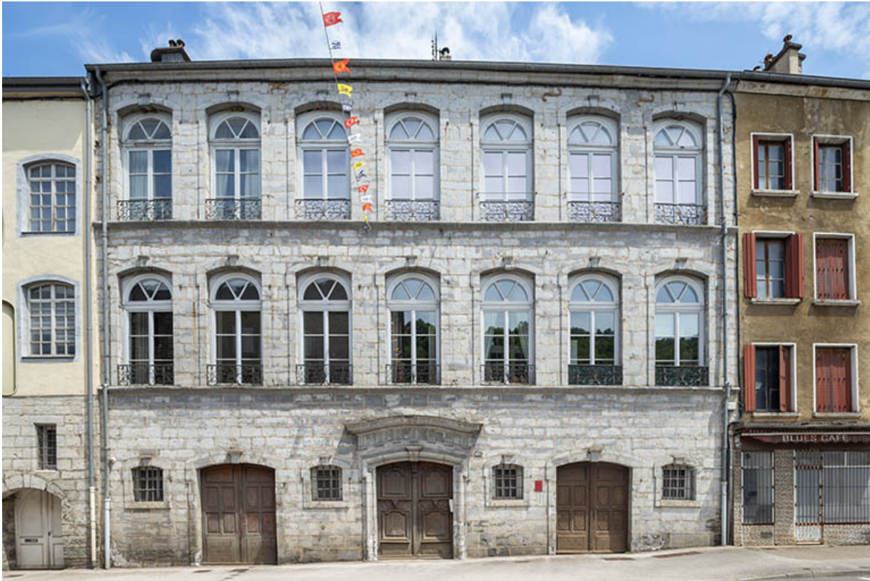
Façade antérieure vue de face.
