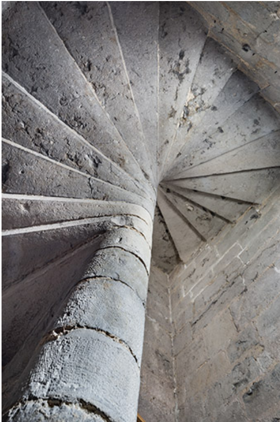
Escalier en vis. Vue en contre-plongée.
