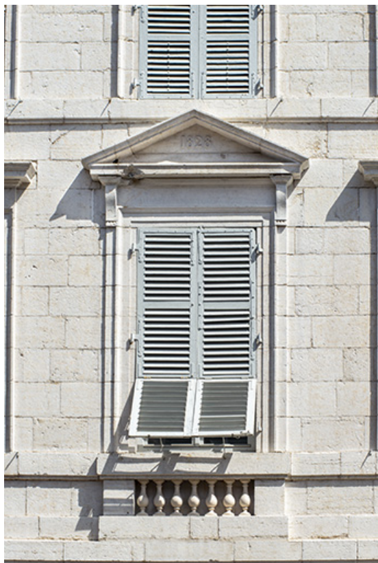
Fenêtre centrale du premier étage.
