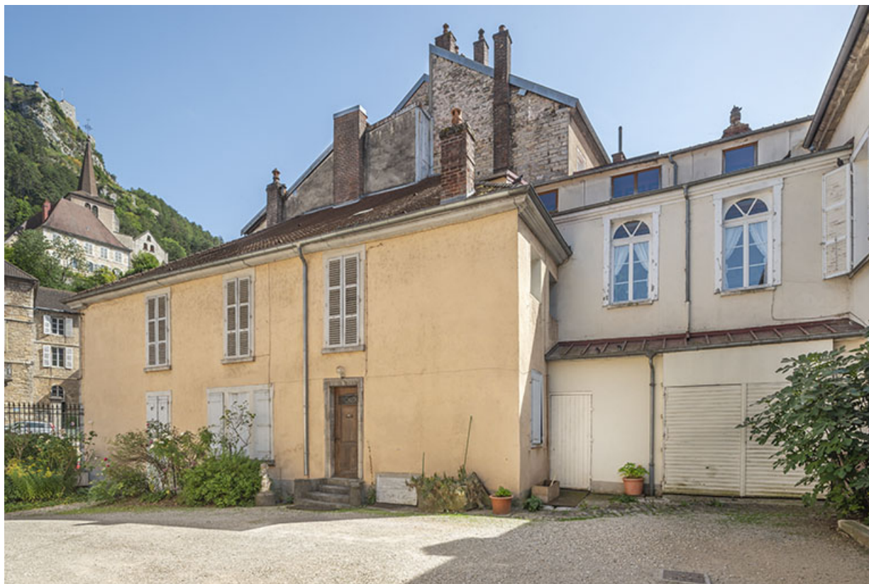
Pavillon sud. Vue de trois quarts.
