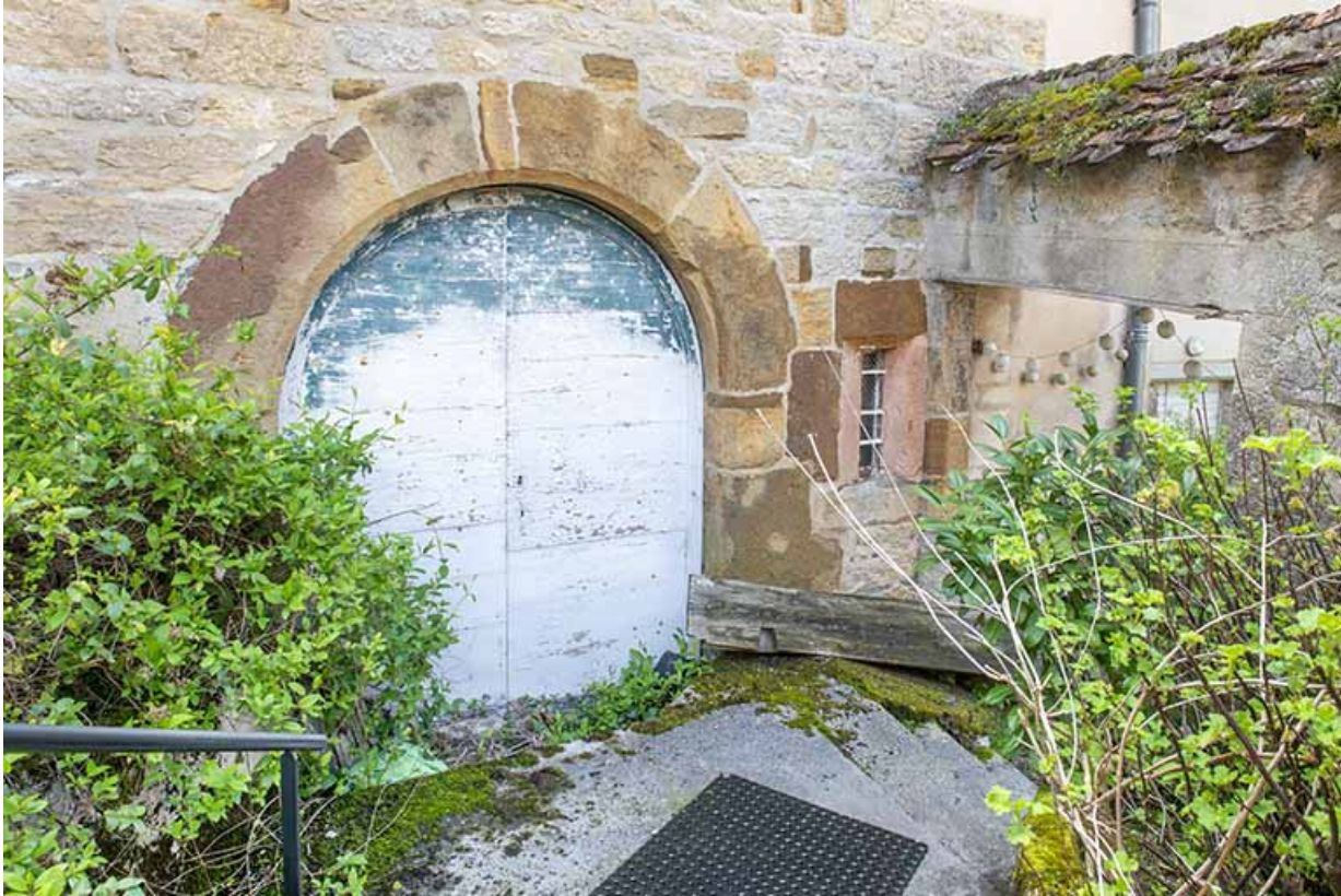
Porte de cave (façade nord).
