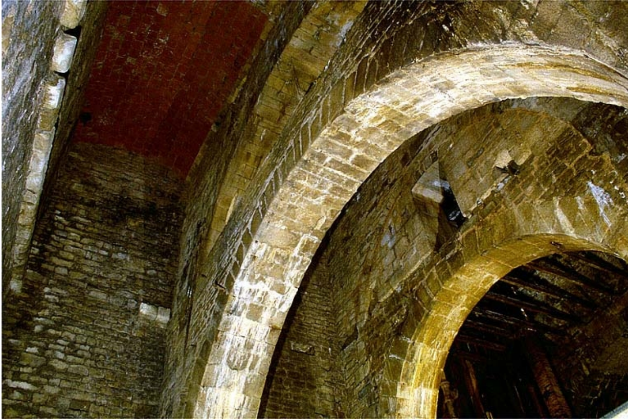
Arcs-diaphragmes et voûtement du puits à Muire.
