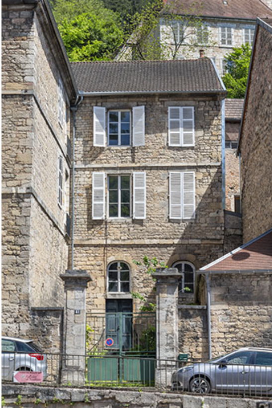
Façade ouest du bâtiment sur cour.
