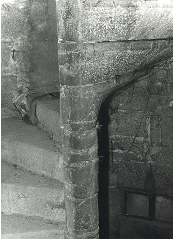
Escalier de la demeure (angle nord-ouest), 1979.
