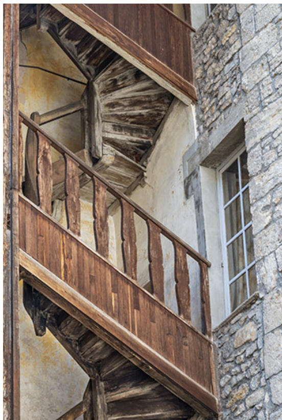
Première cour. Escalier hors-oeuvre.
