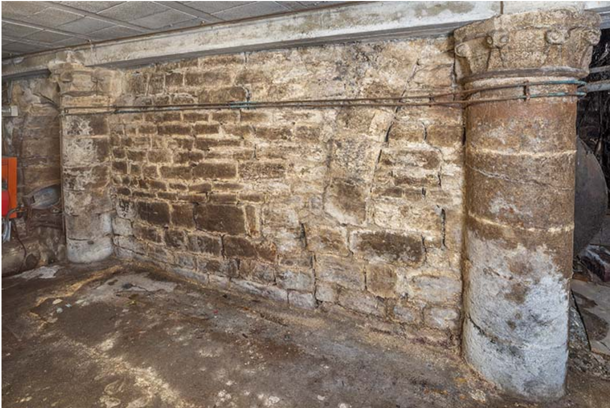
Sous-sol : colonnes et chapiteaux.
