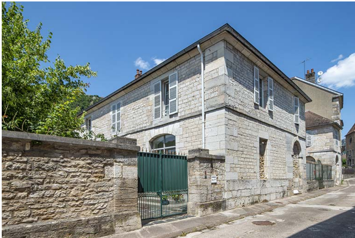
Aile sud. Façade sur le jardin.
