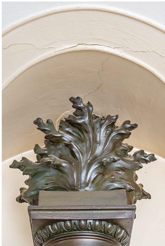
Cheminée. Couronnement du conduit d'évacuation (grès flammé).
