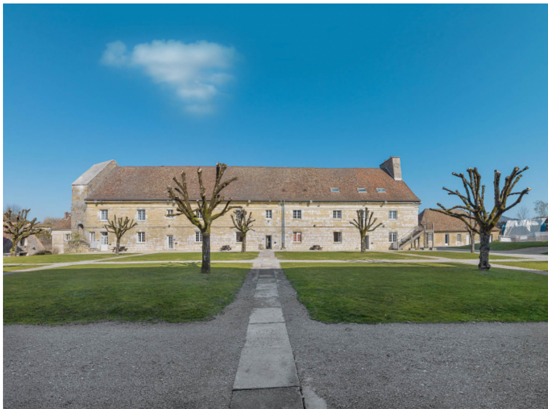
Caserne U : façade antérieure.
