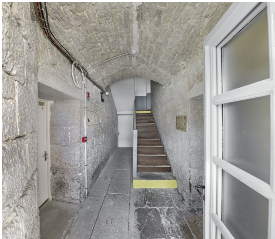
Caserne U, rez-de-chaussée : cage d'escalier.
