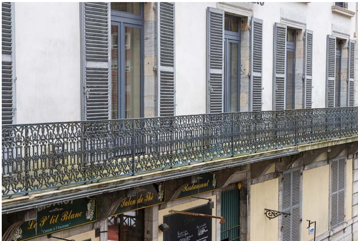
Façade nord, balcon.
