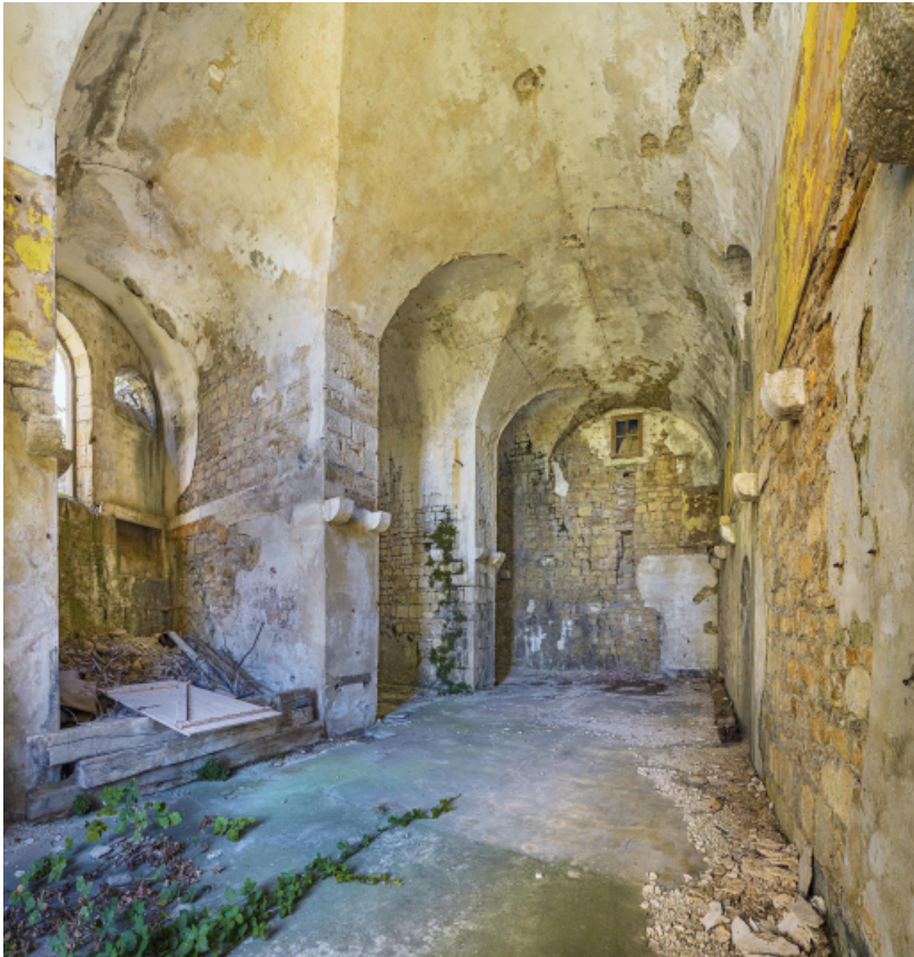
Vue intérieure du bâtiment casematé.
