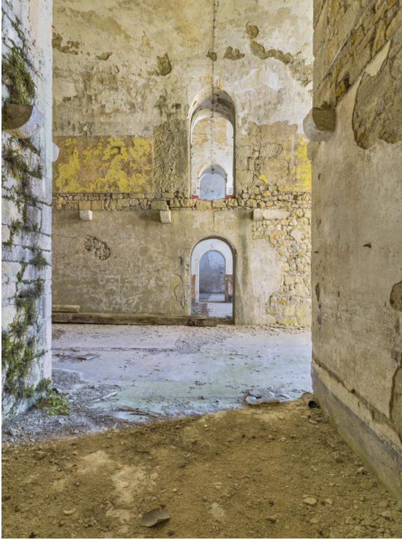
Vue intérieure du bâtiment casematé : les corbeaux attestent l'existence d'un plancher disparu. 39, Salins-les-Bains chemin Touillon, lieudit : Belin
