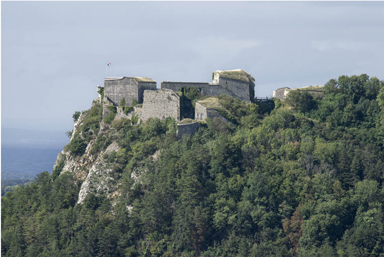
Fort Belin : vue générale du front sud.
