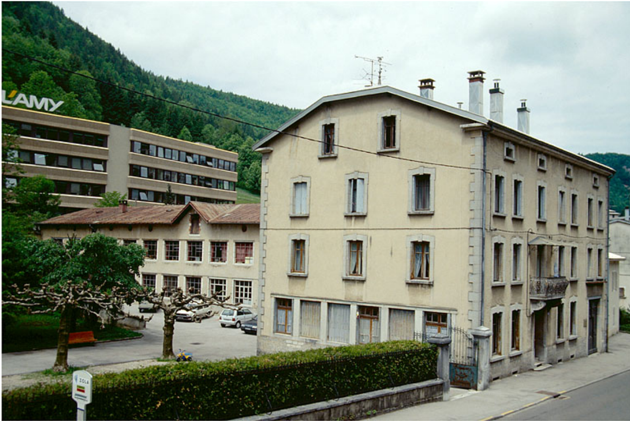
Logement patronal et atelier de fabrication.
