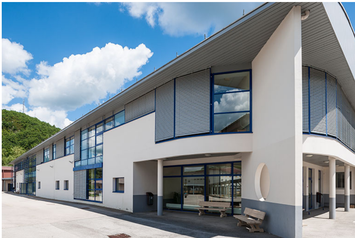
Ateliers : détail des façades et entrée.
