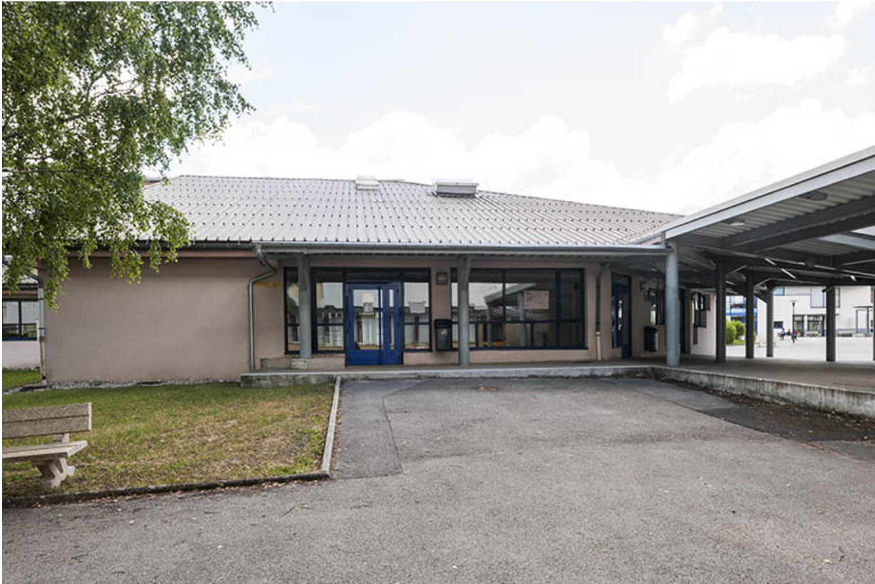
Restauration, façade Ouest, entrée.
