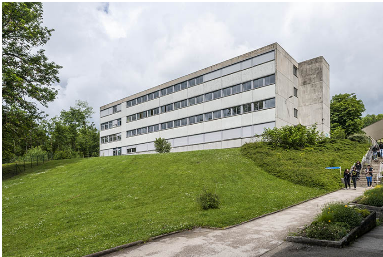
Façade sud de l'internat de garçons.
