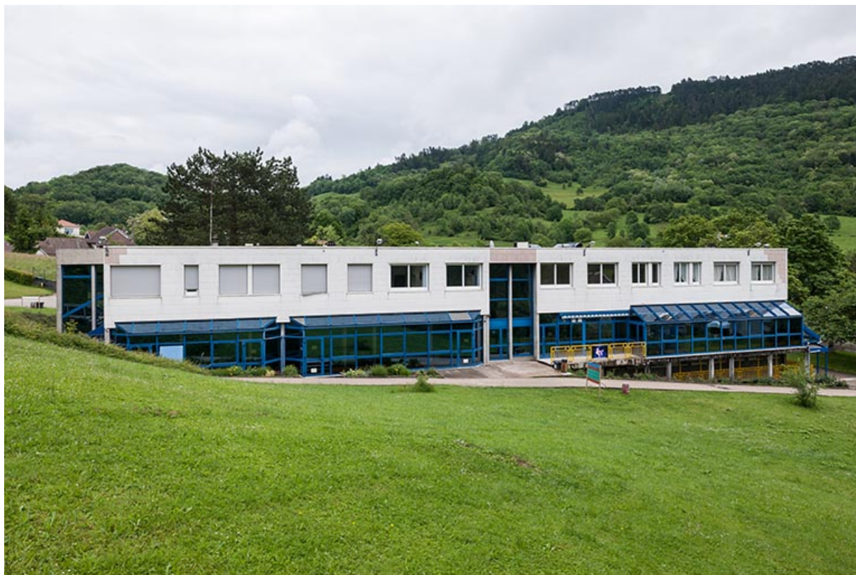
Façade antérieure occidentale de la restauration.
