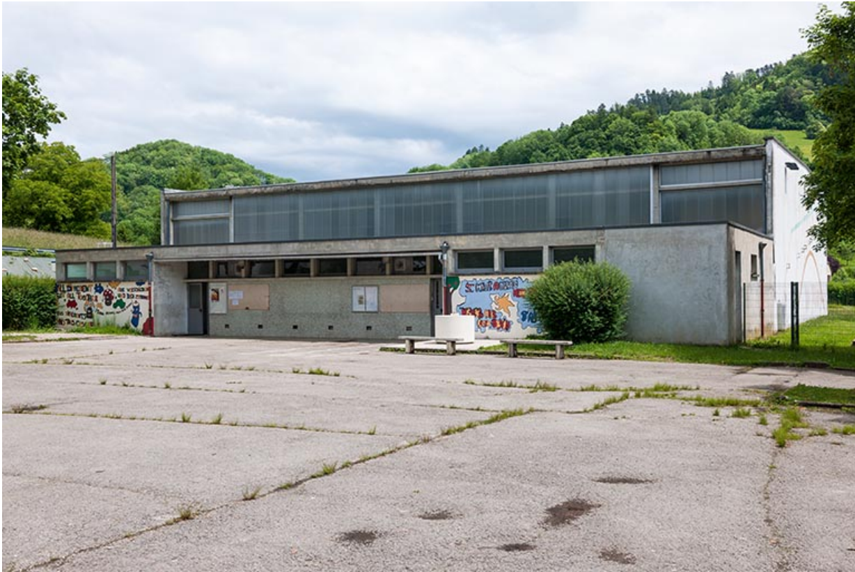
Façade antérieure du gymnase.
