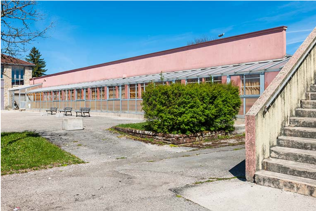
Atelier, site avenue Edouard Herriot : façade antérieure.
