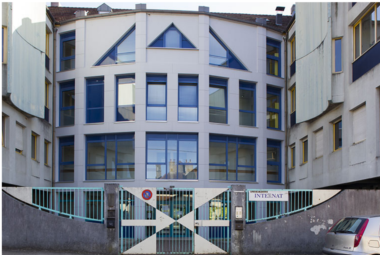
Internat : façade Nord, détail.
