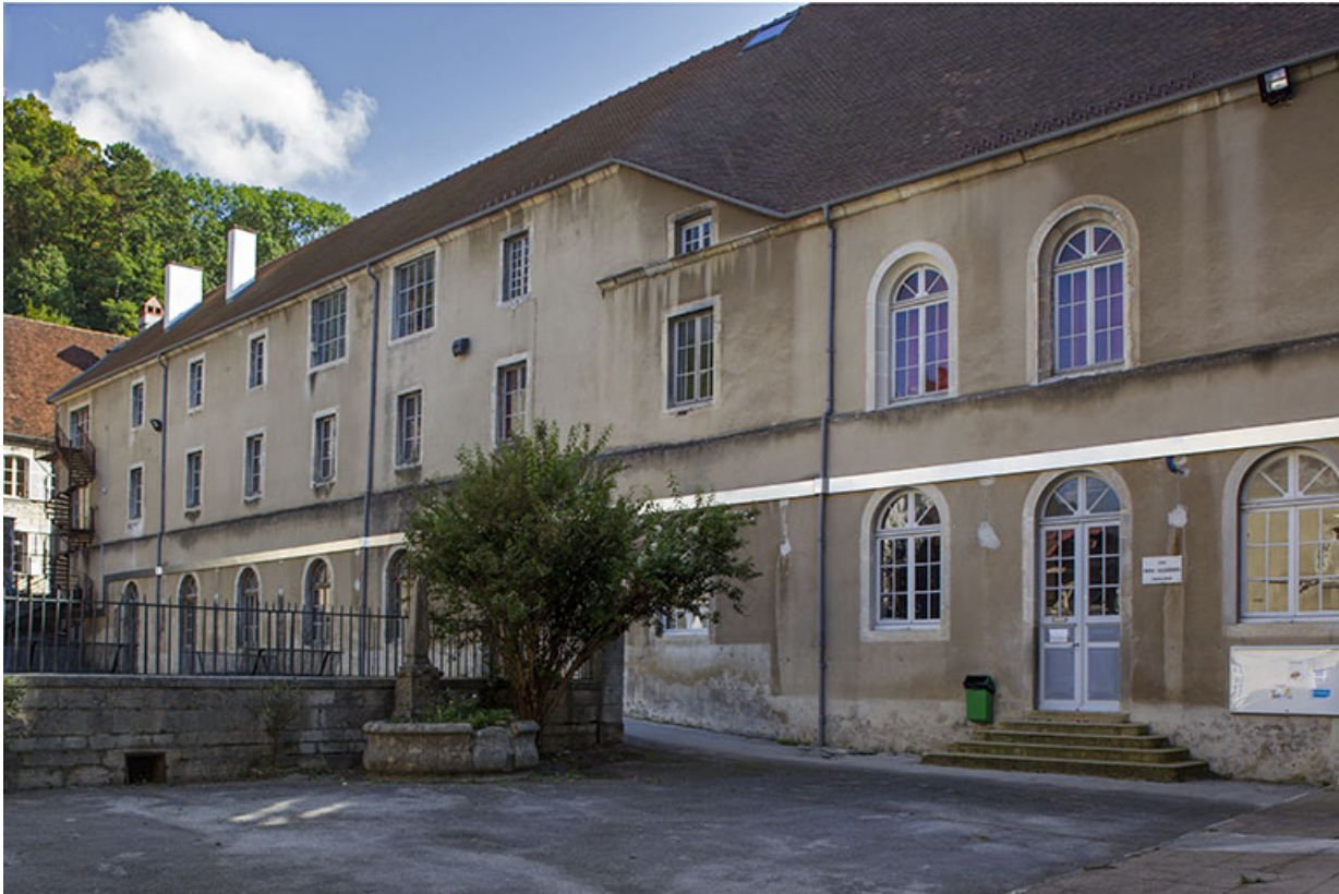
Site des oratoriens : façades sur cour.
