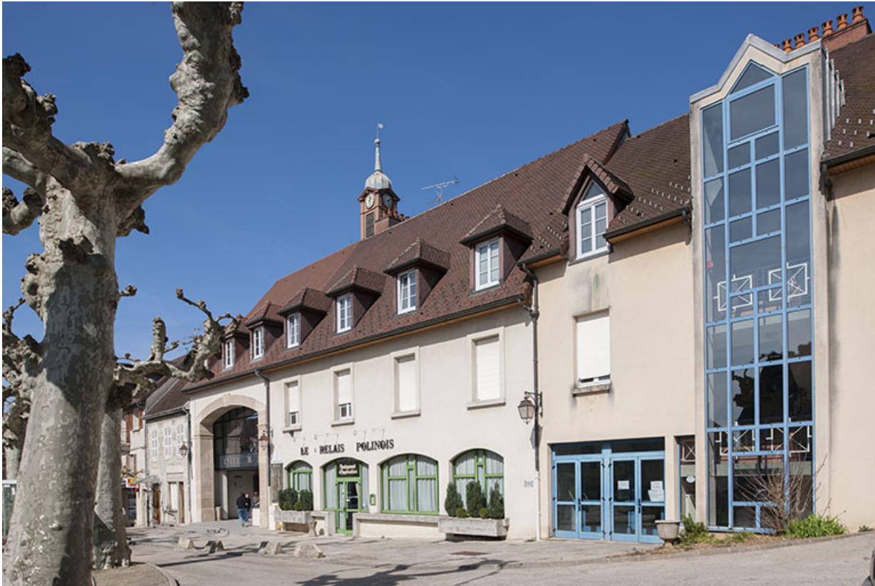
Poligny, lycée Hyacinthe Friant : restaurant d'application.
