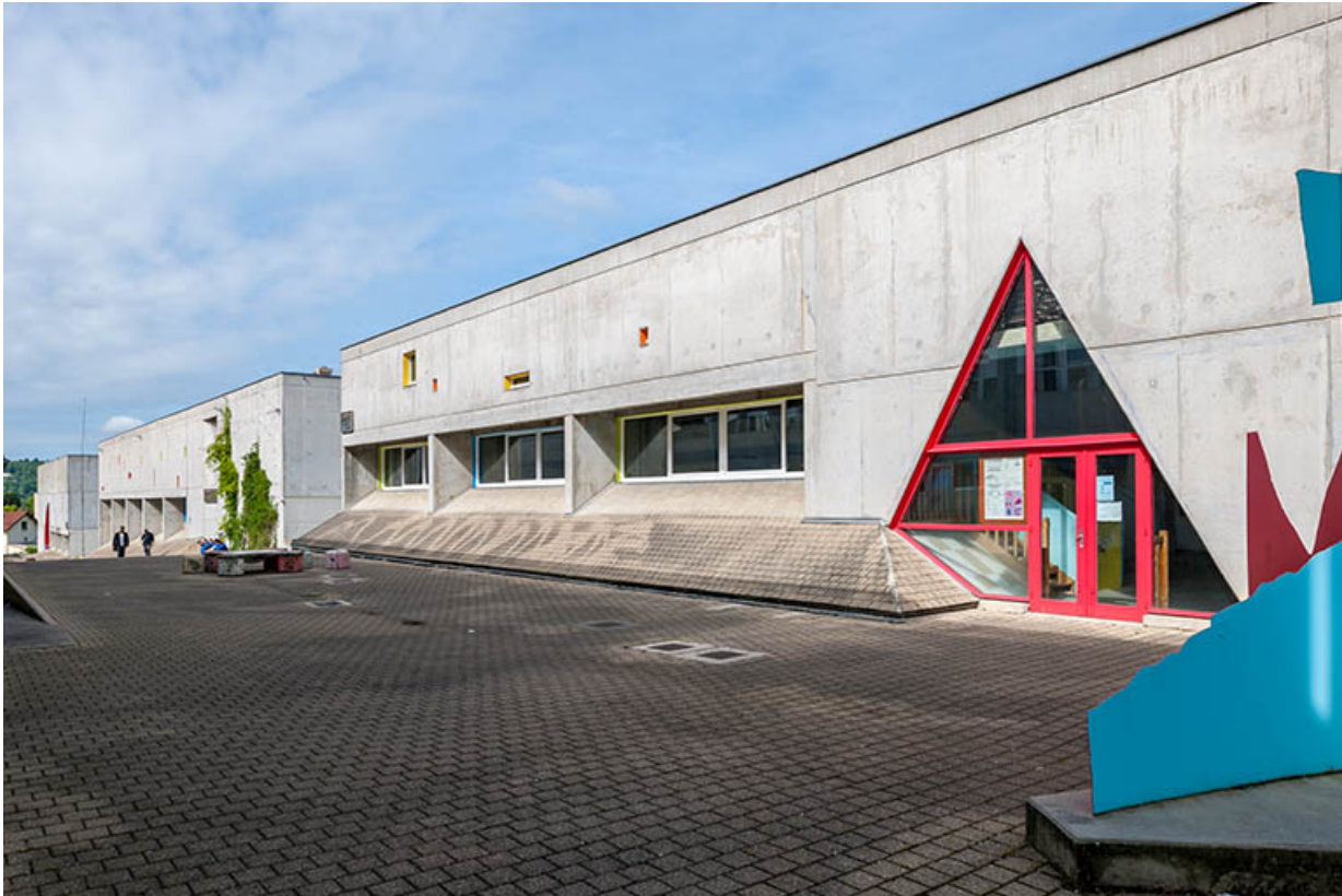
Atelier bois : façade antérieure sur rue intérieure.
