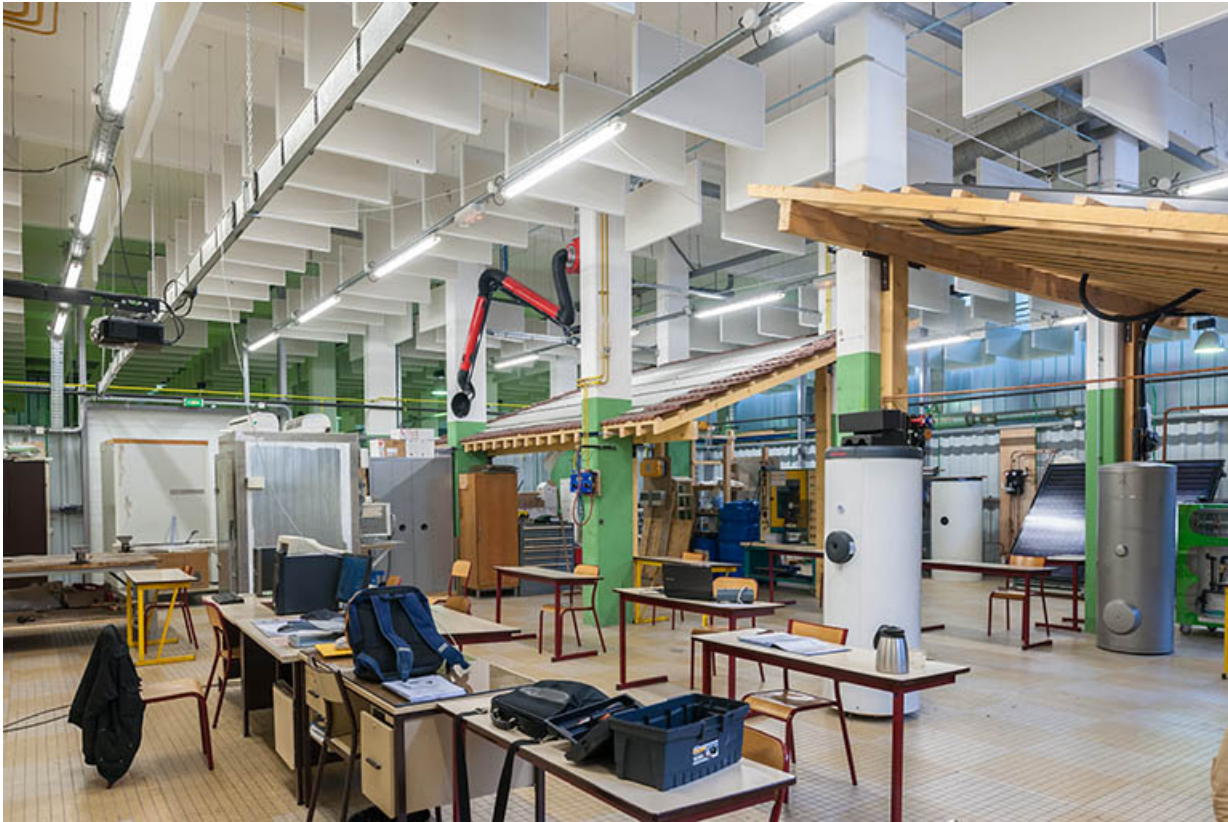
Atelier formations sanitaire et thermique : intérieur
