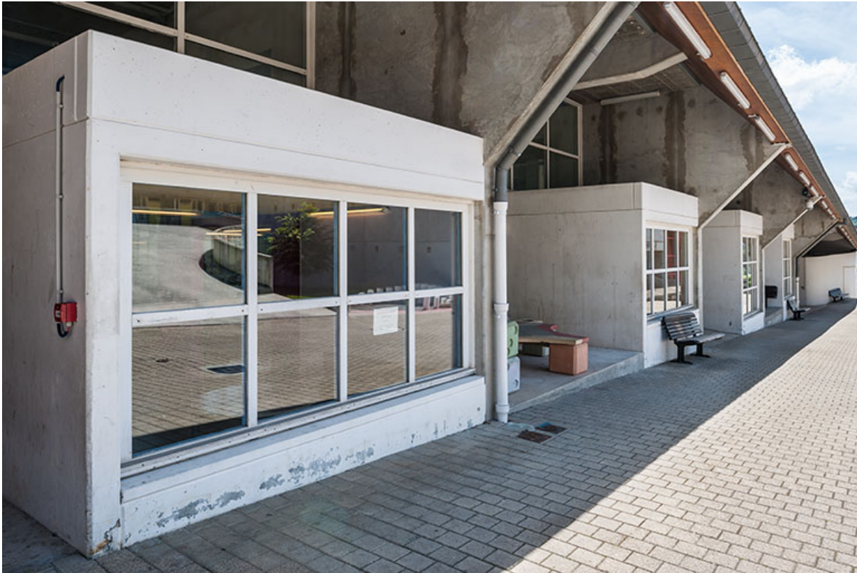
Façade en rez-de chaussée du bâtiment internat-administration
