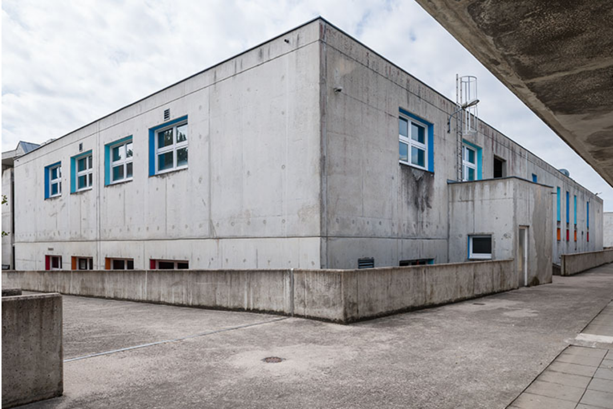
Atelier métal : façade latérale.
