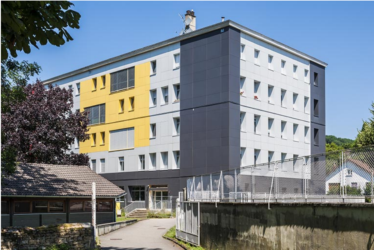
Façade latérale de l'internat après rénovation.
